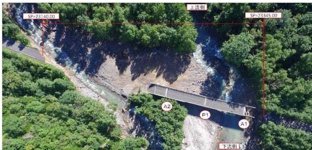
【提供：北海道上川郡美瑛町 水楽橋 平成 28 年 8 月 25 日撮影】
