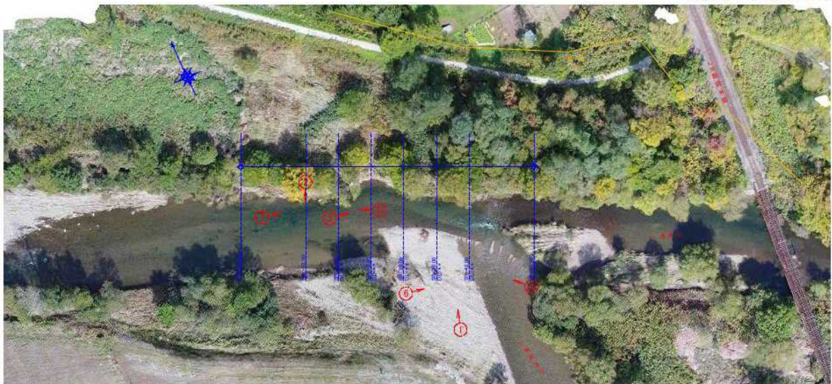
①被災箇所全景
