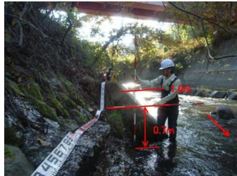
豪雨出水により、石積み護岸の下部が露出したため、根継工にて申請
