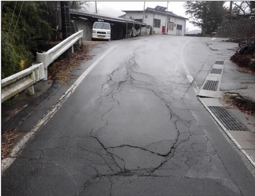
被災状況（凍上による路面の破損）
