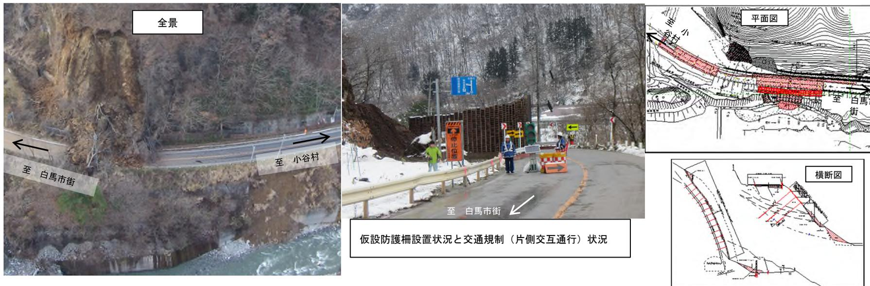
長野県神城断層地震地震により道路山側斜面が崩壊し、全面通行止となった。当該路線は、重要な幹線道路のため、災害査定を待たずに緊急かつ早期に交通を確保する必要があった。このため、崩落土除去の後、斜面再崩落防止のための仮設モルタル吹付工及び吹付作業スペースの確保と交通確保（片側交互通行）のための仮設防護柵工については、本復旧の安全対策としても必要となるため、応急本工事として申請した。
