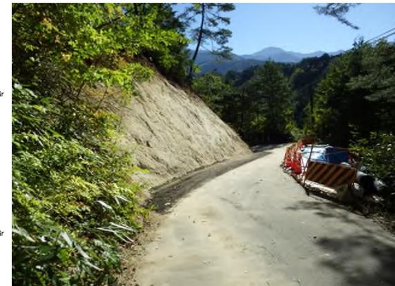
平成27年10月1~2日の豪雨に伴い、路面からの雨水の集中により、路肩が崩落した。町道の奥には民家、射撃場があり、長期間通行止とするには影響が大きいため、復旧工法の中で最も安価となる工法を確認し、山側斜面の掘削を応急本工事として着手し、幅員を確保した。
