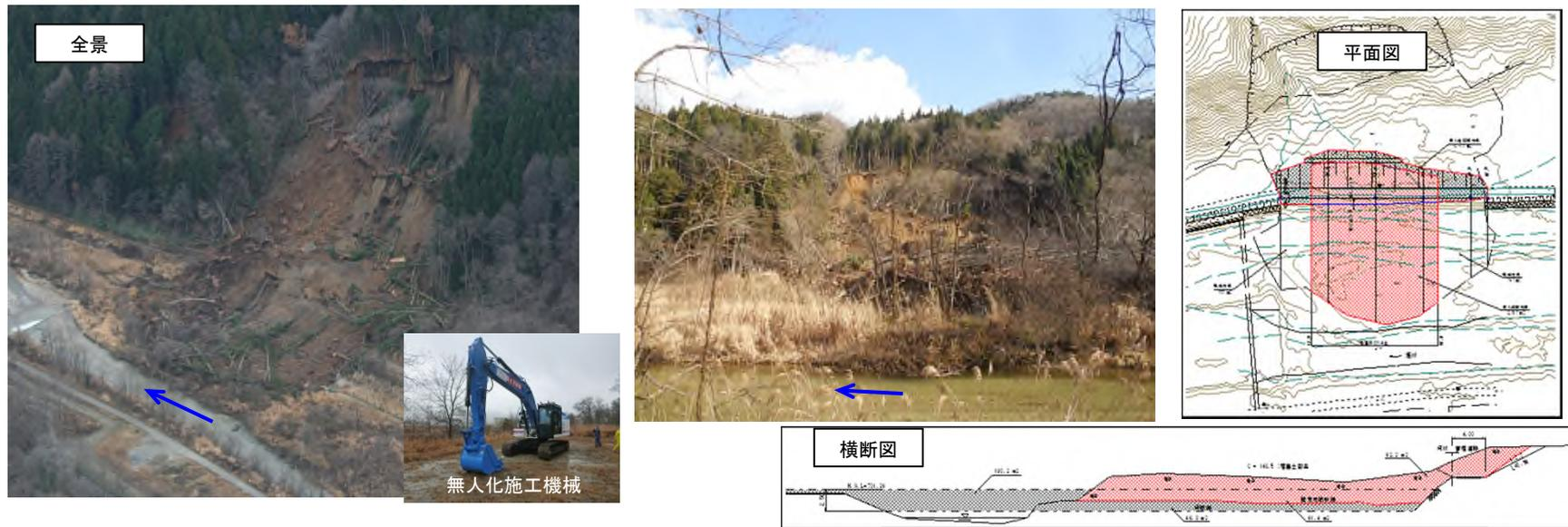
長野県神城断層地震により、姫川左岸側の山腹約1万m<sup>3</sup>が崩壊。河川断面の約2／3が埋塞し、除去工事を全部応急工事により実施した。
